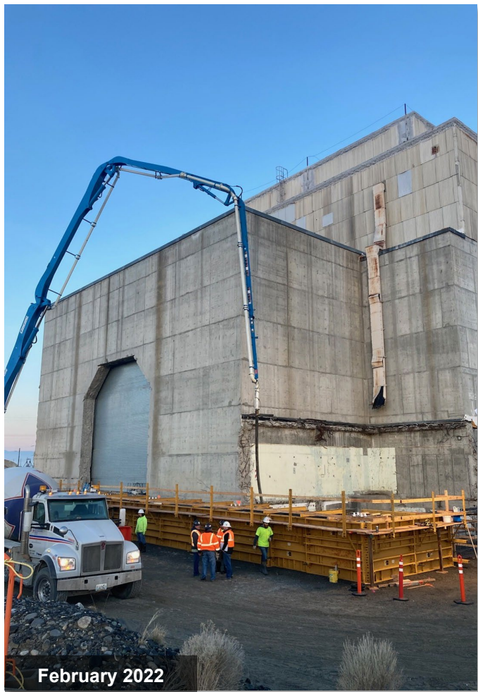
K East foundation concrete pour
