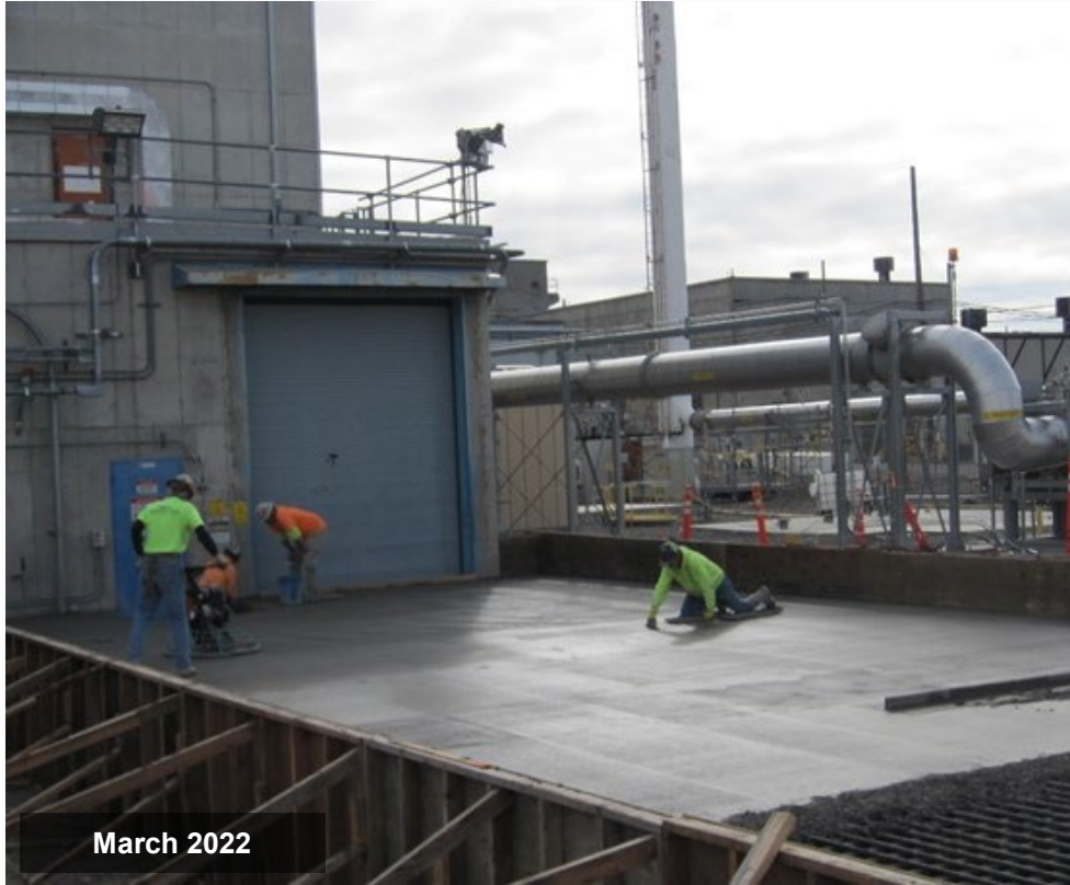
Truckport transfer pad concrete pour
