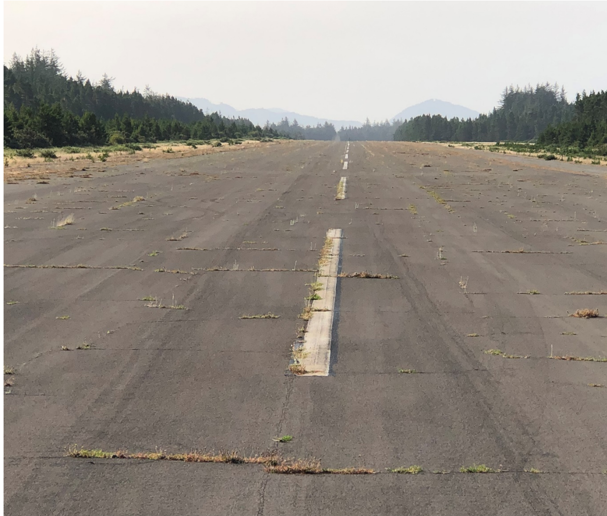
Cape Blanco (rwy rehab) $3.5M
