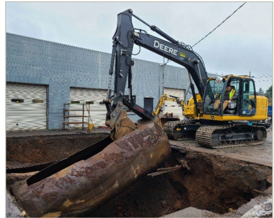
Asesor ambiental extrayendo un antiguo tanque de almacenamiento subterráneo de acero.
