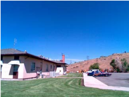
SE Falling Hazard
