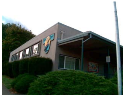
SE Falling Hazard
