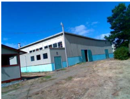
SE Elevation View
