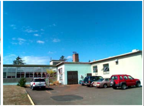
SE Falling Hazard
