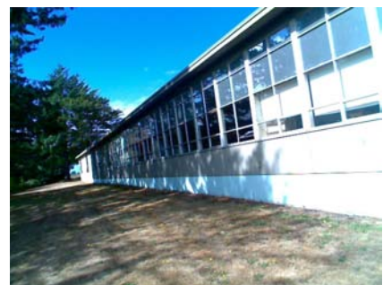
SE Elevation View
