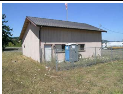
SE Elevation View
