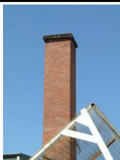
E Falling Hazard URM
