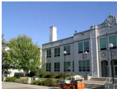
SE Falling Hazard possible URM
