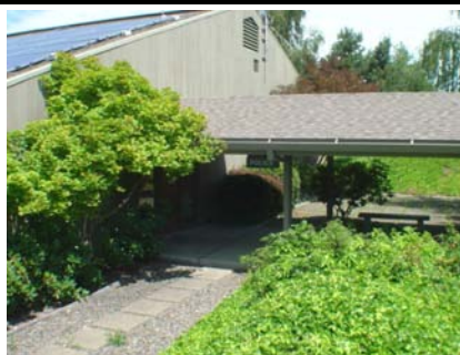
SE Falling Hazard
