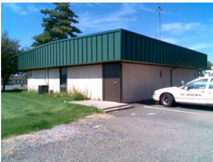
SE Elevation View
