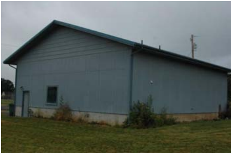
SE General Site
