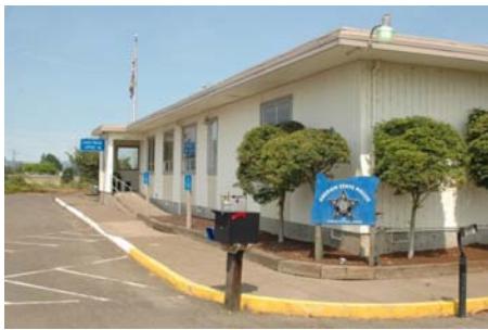
SE General Site
