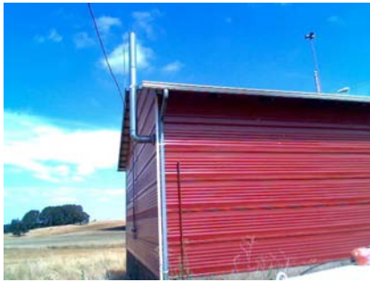
SE Elevation View
