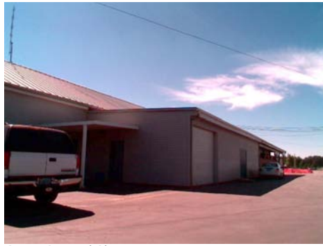
SE General Site
