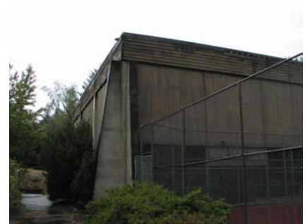
SE Elevation View
