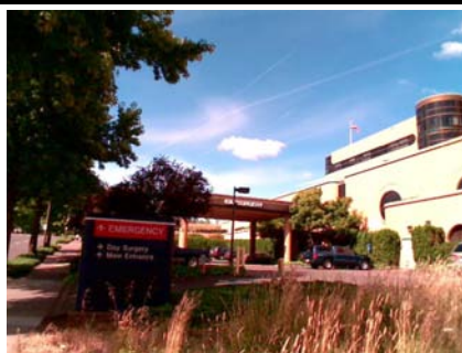
W Falling Hazard
