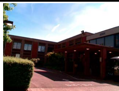
NE Falling Hazard
