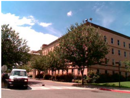
SE Elevation View
