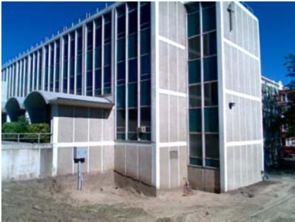
SE Elevation View
