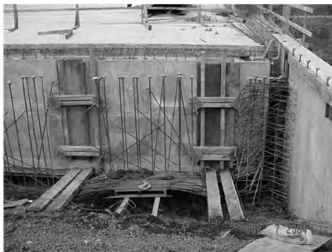
Form Up and Pour Blockouts
