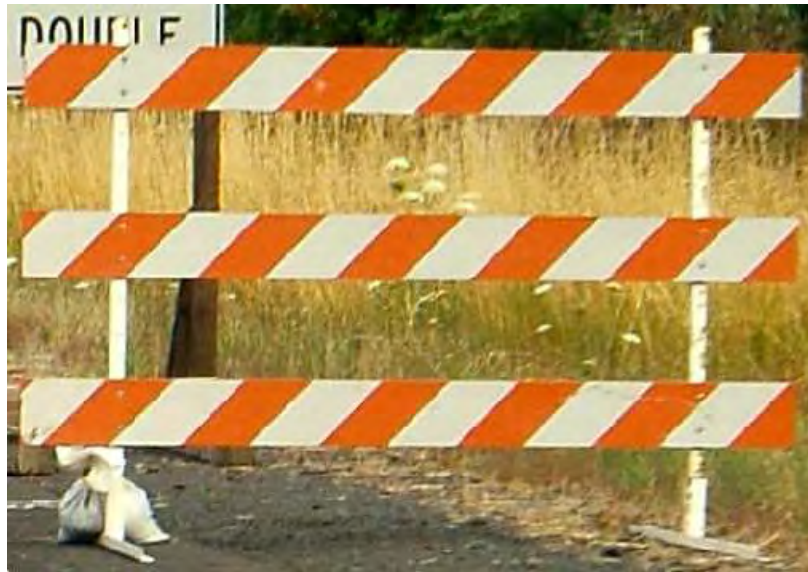
Figure 2.4: Type III Barricade (ODOT 2014)
