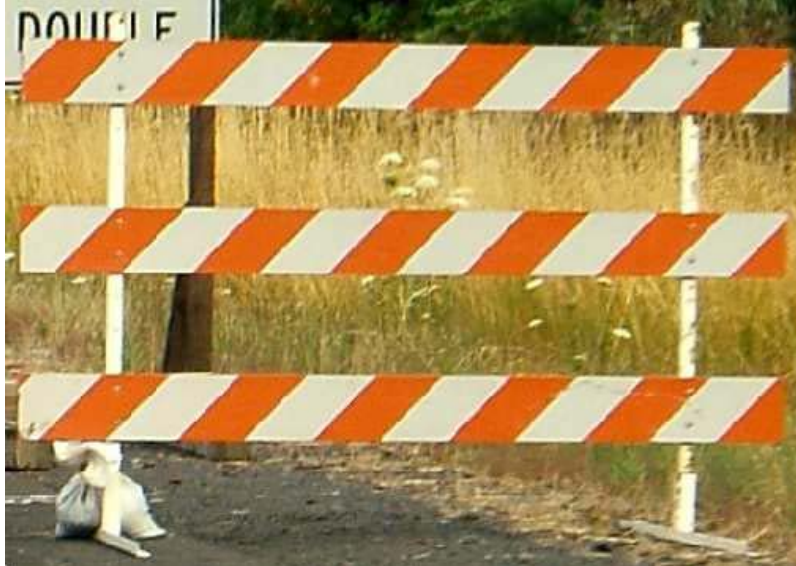
Figure 2.4: Type III Barricade (ODOT 2011)
