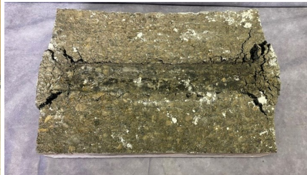
(d) Tested CLRS block sample with cracking
