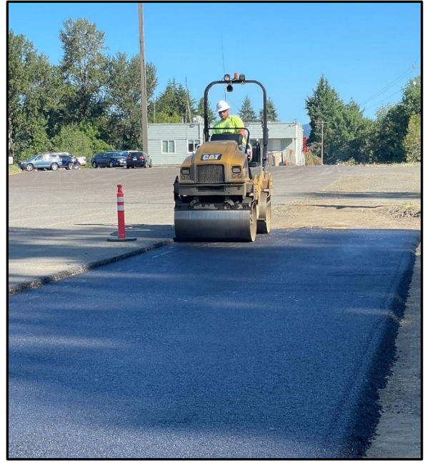
(d) Compaction process
