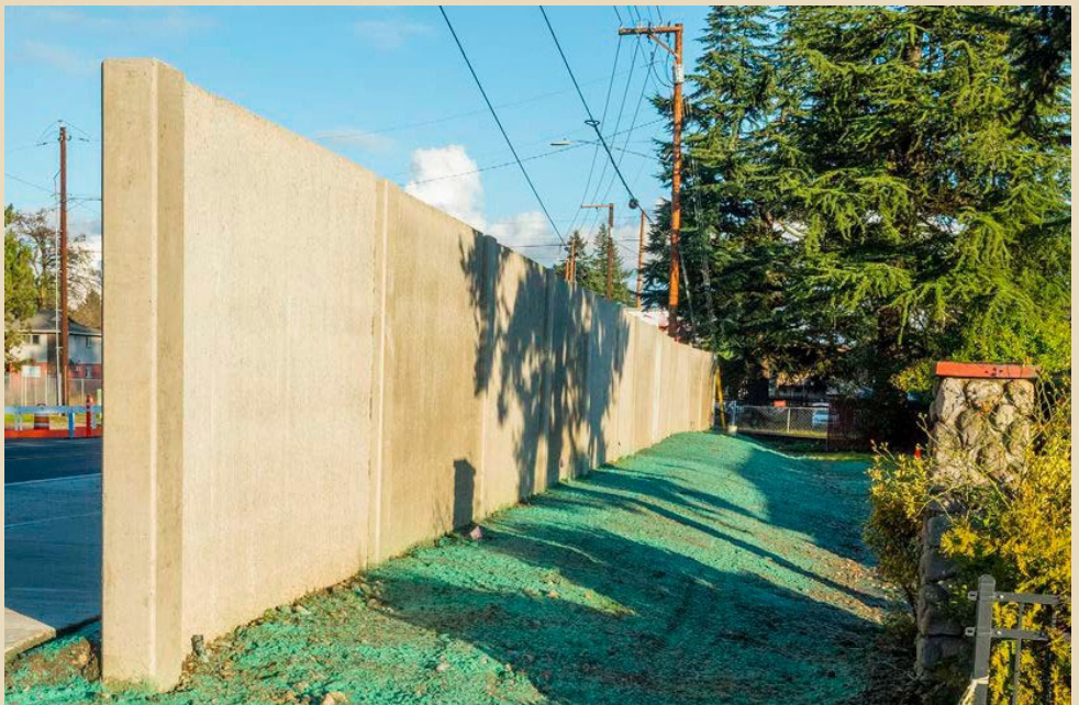
Pared a prueba de sonido construida en la Fase 1 del proyecto
